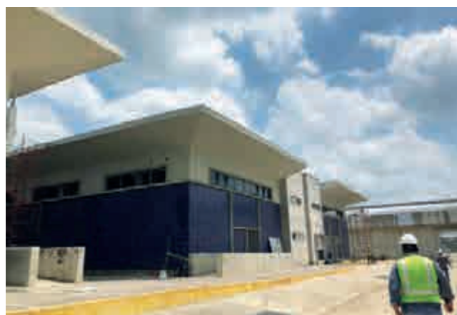
Construcción del Complejo Penitenciario Papantla. Prevención y Readaptación Social.
