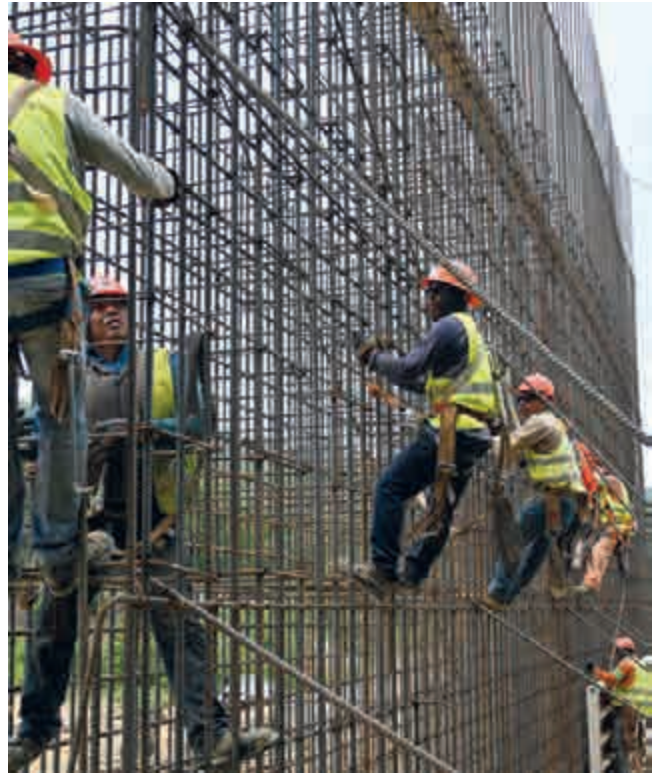
Trabajos en Boca del Cerro, Tenosique correspondientes al Tramo 1. Fondo Nacional de Fomento al Turismo.
